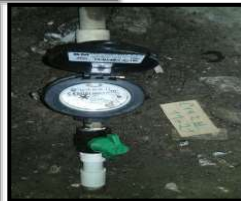
Instalación de 1850 micro medidores y válvulas antifraude
