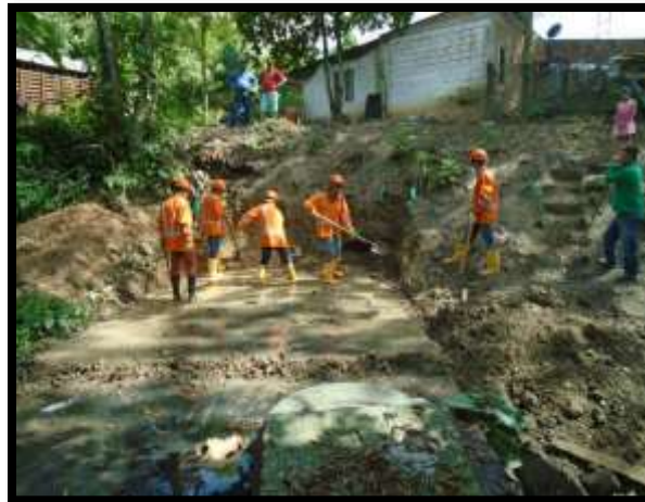
Un (01) pozo séptico rehabilitado
