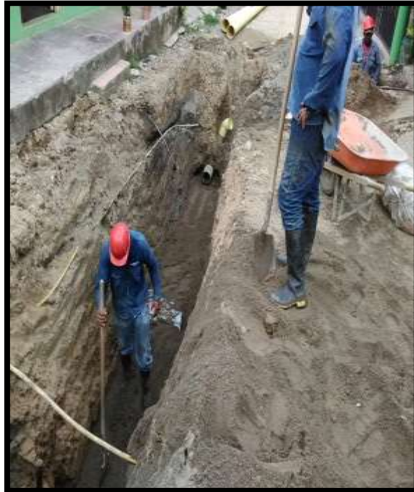
Instalación de 945 ml de redes de Alcantarillado Sanitario en el Sector Cristo Rey
