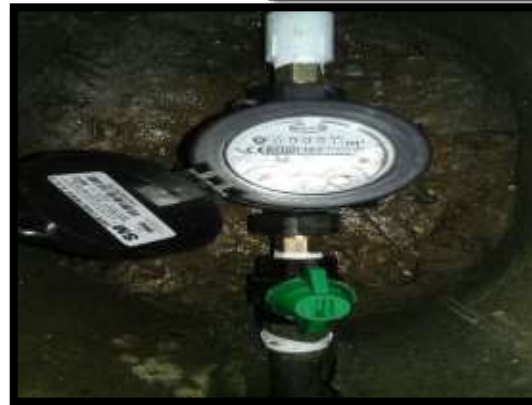
Instalación de 1850 micro medidores y válvulas antifraude
