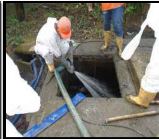
Un (01) pozo séptico rehabilitado
